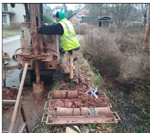
Technologické pažení na vrtu JV8
